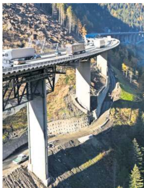
Die Luegbrücke wird zu dem Nadelöhr der Brenner-Route.
