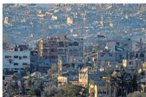
Der Gazastreifen bietet ein völliges Bild der Zerstörung. Foto: dpa/Ariel Schallit
