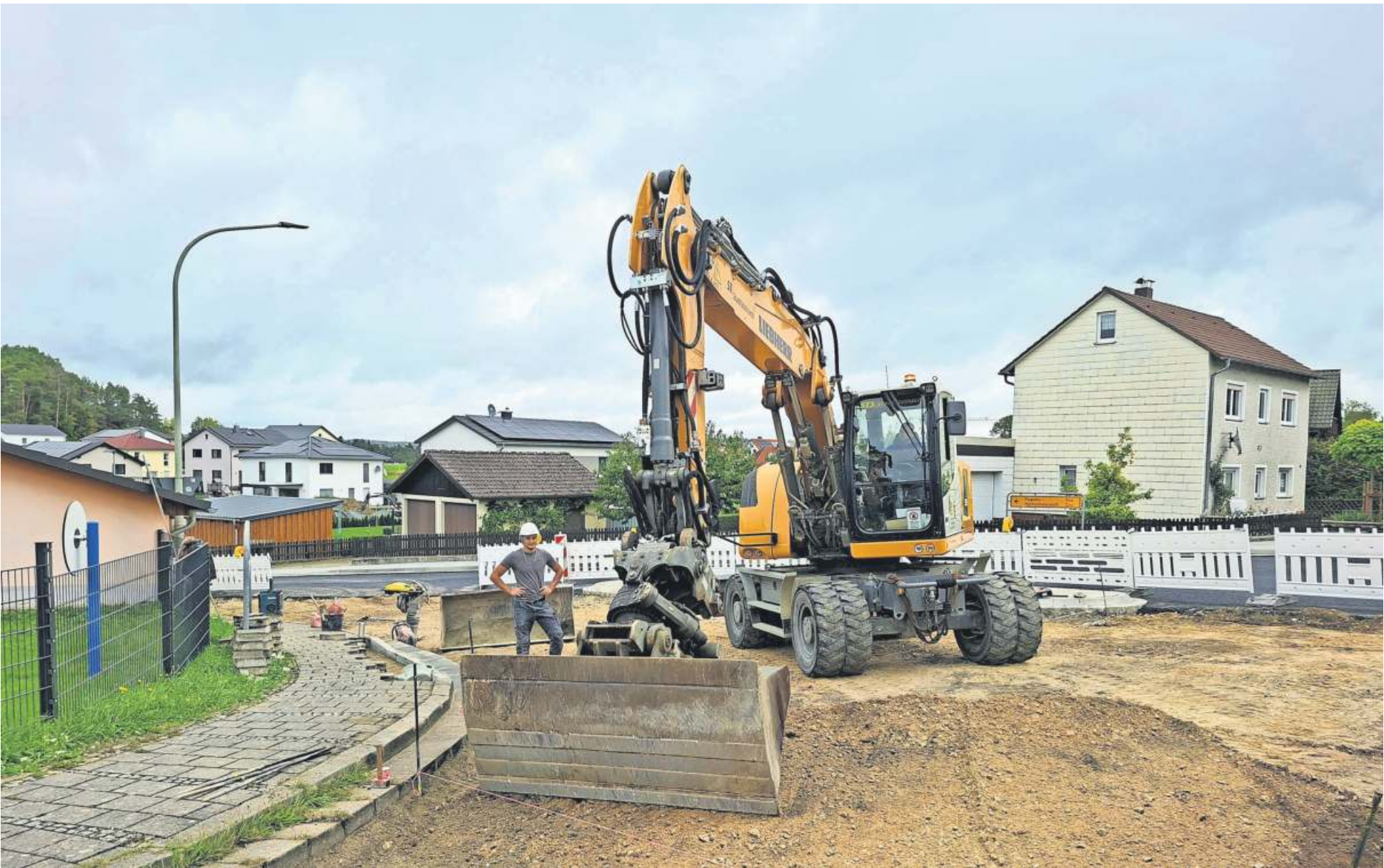
Die Arbeiten vor dem Schützenhaus in Horlach dauern an. Am Donnerstag kann dort die Asphaltdecke aufgetragen werden.
