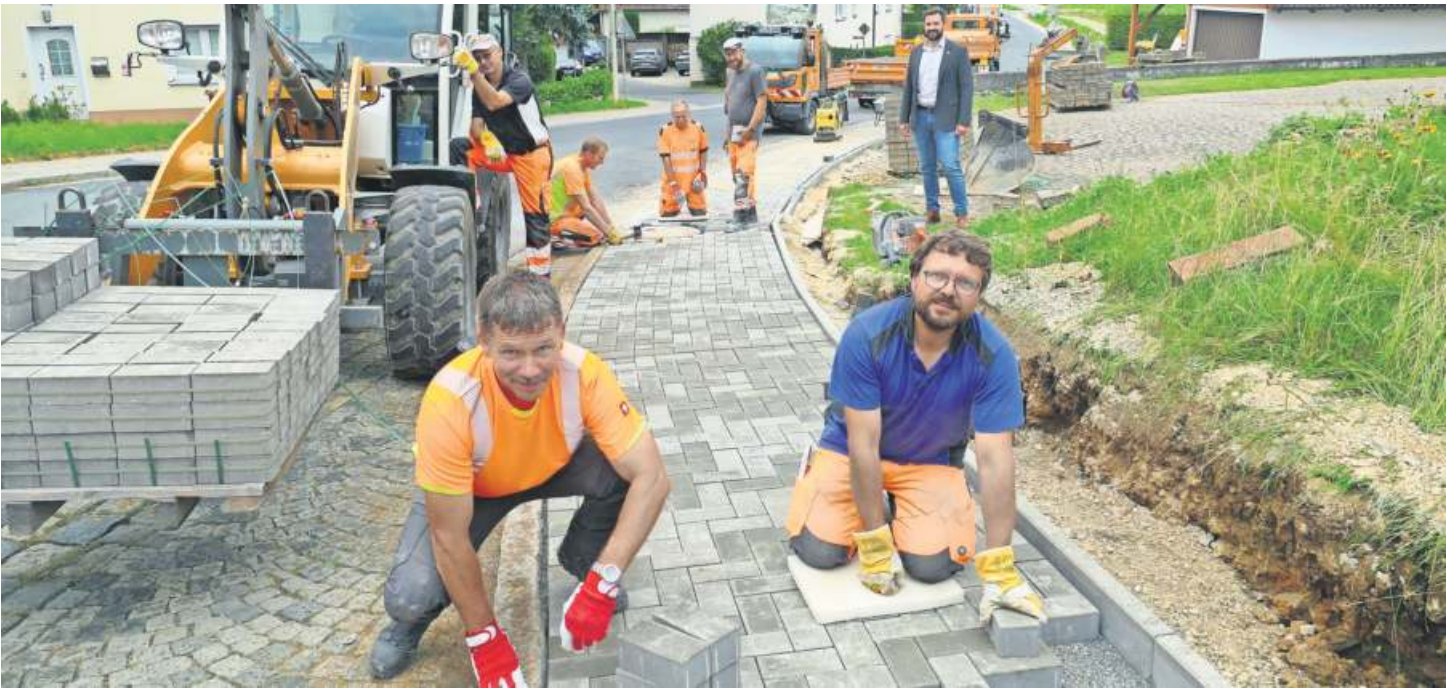
Der 80 Meter lange, neu geschaffene Gehweg bietet in Zukunft wesentlich mehr Verkehrssicherheit für Passanten.
