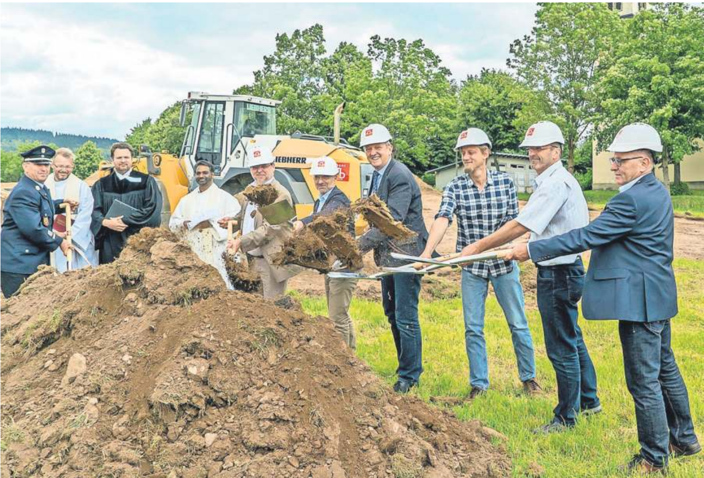
Das Foto entstand im Juli 2017 beim Spatenstich zum Feuerwehrhaus in Weidenberg am Rosenhammer. Es war eines der großen Projekte, das Hans Wittauer (Fünfter von links) als Bürgermeister begleitet hat.
