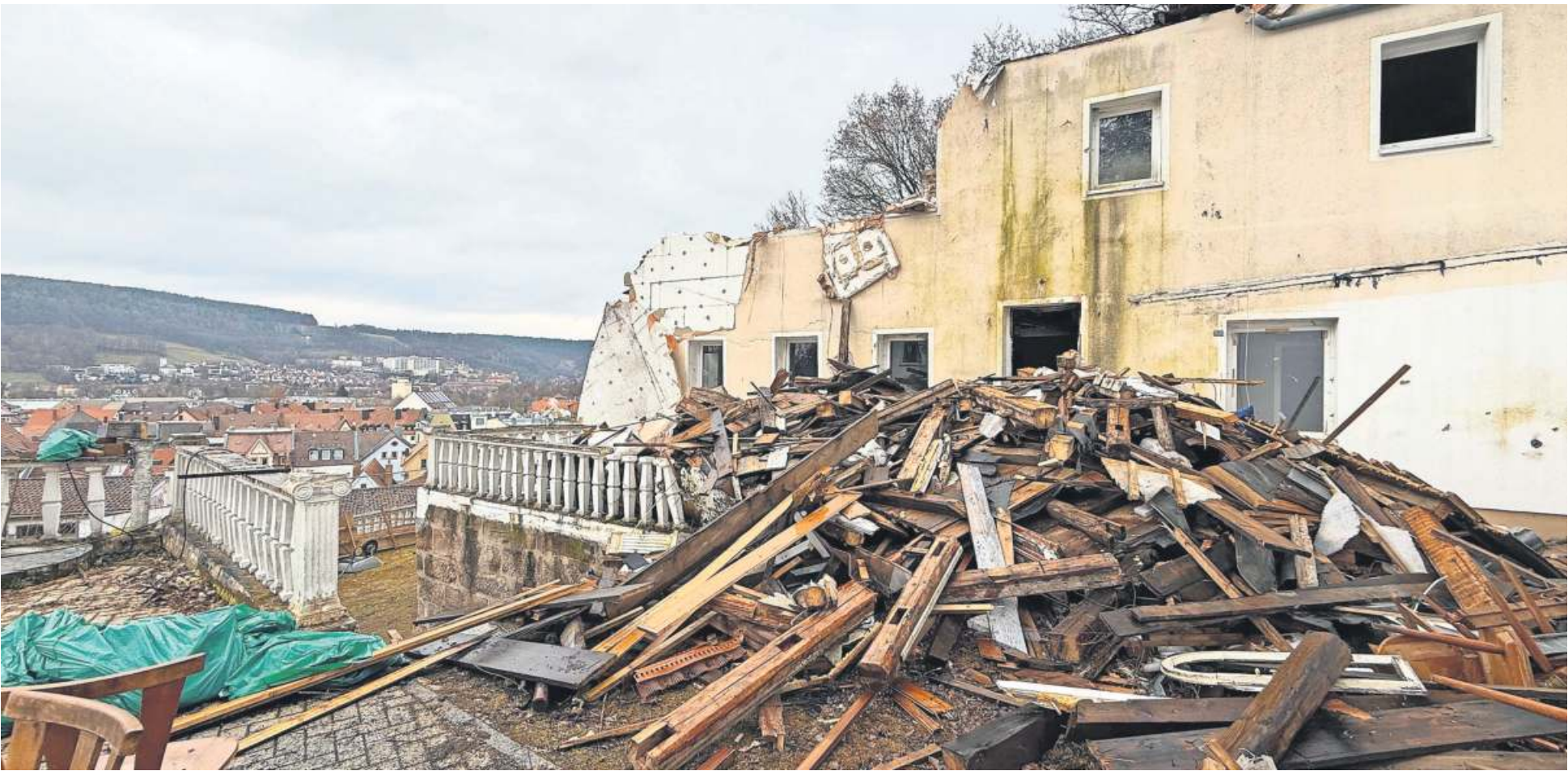
Über ganz Kulmbach schaut man von der Terrasse. Unzählige Gäste haben das genossen. Was nach dem Bergschlösschen kommt? Das ist noch nicht beschlossen.
