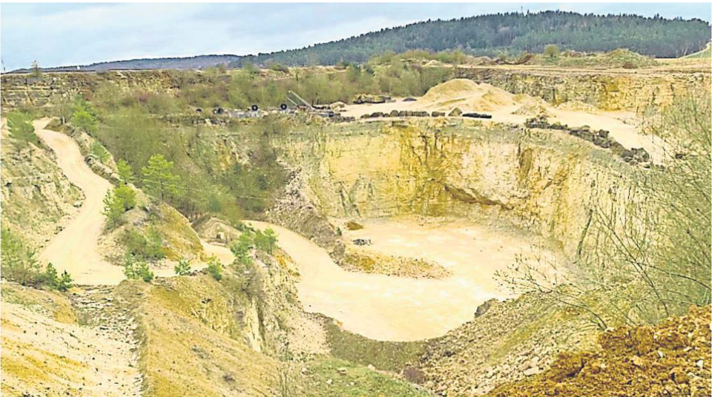
Im Lauf von 70 Jahren entwickelte sich der Steinbruch Lodes von einer kleinen Grube rund 40 Meter in die Tiefe.
