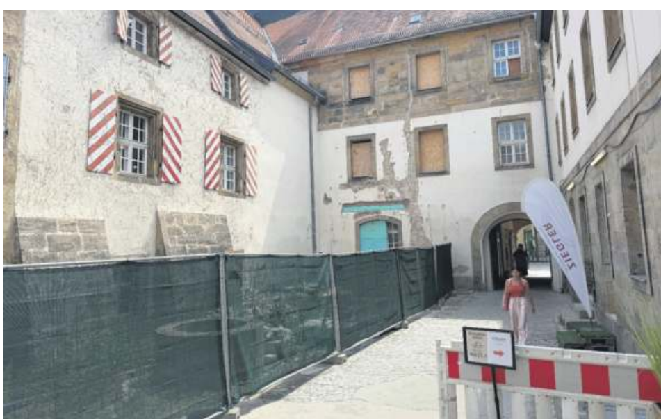
Blick in den Innenhof: Die Sanierung des Bürgerspitals dauert weiter an.
