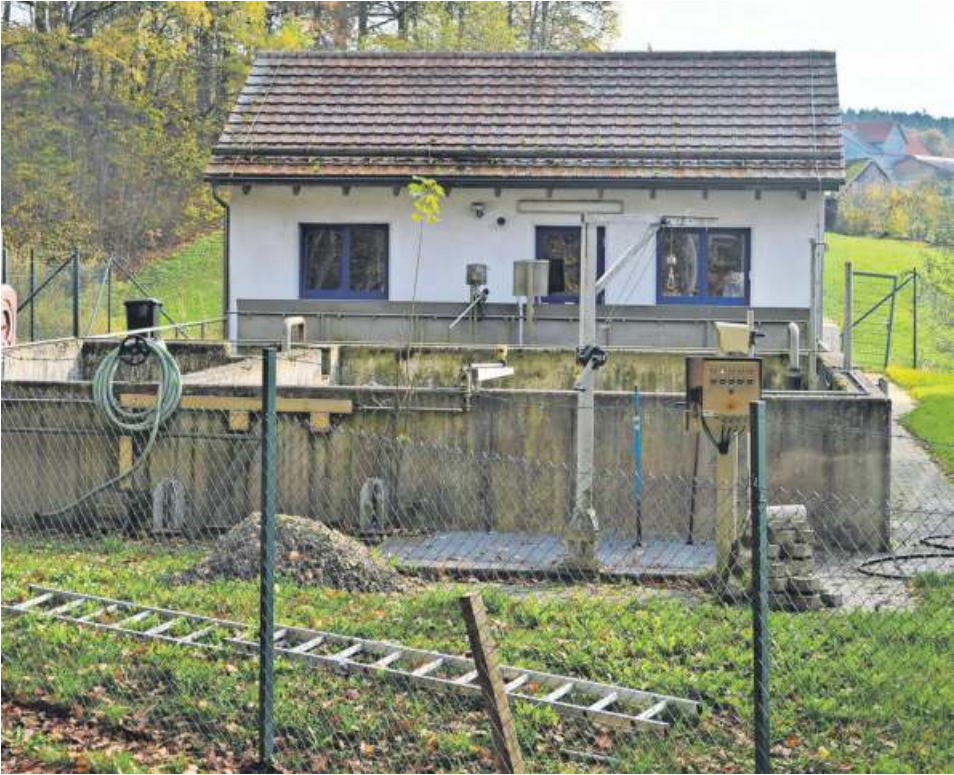
Investitionen in die kleine Emtmannsberger Kläranlage zahlen sich jetzt bei der Abwassergebühr aus.
