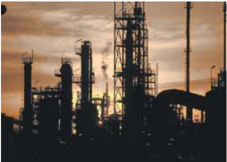
Industrieanlagen der Mineralö Raffinerie Oberrhein (MiRO) im Gegenlicht. Die Internationale Energieagentur (IEA) warnt vor einer anhaltenden Verknappung des weltweiten Dieselangebots bis weit ins Jahr 2027 herein.
